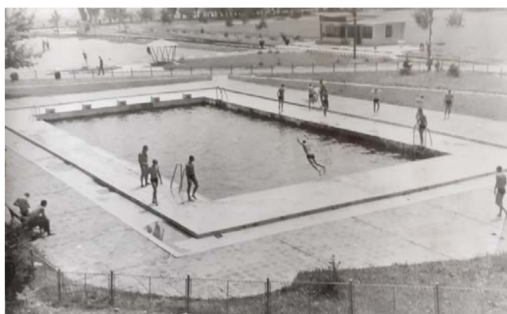
Плувният басейн в района на ПЖИ „Тодор Каблешков“
